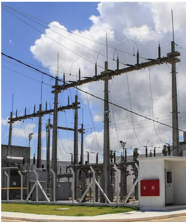
LEGENDA: B18/B19 - SUBESTAÇÕES DE ENERGIA ELÉTRICA (69KV/13,8KV)
