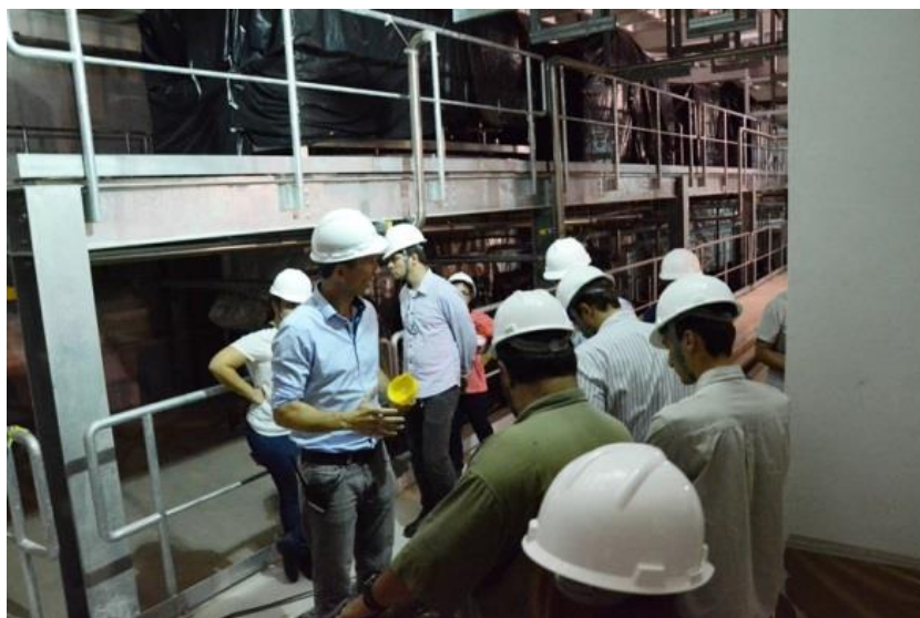
Figura 8 - Equipamentos Instalados no subsolo de B02
