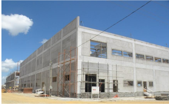
- Construção do Bloco B05 -
