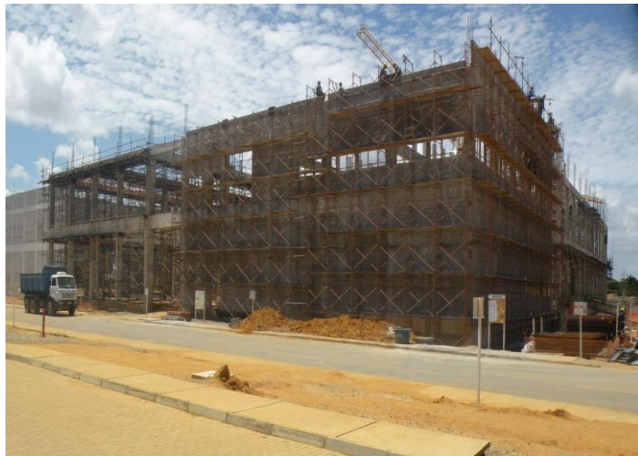
- Construção dos Blocos B03 e B04 -
