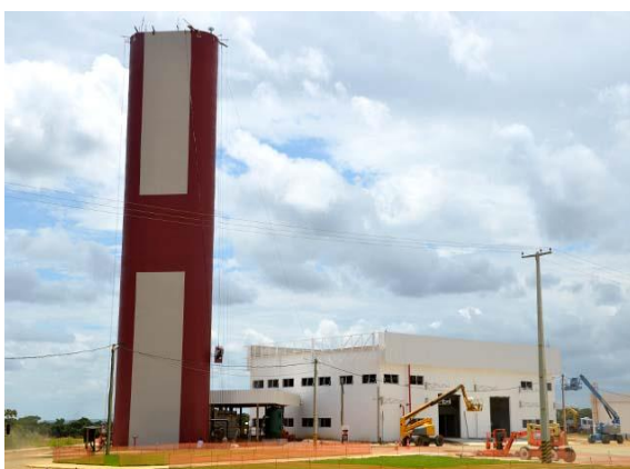
- Reservatório Elevado e Bloco B12 –
