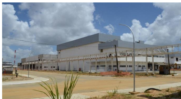
- Vista dos Blocos B01 e B02, jan/2015 -
