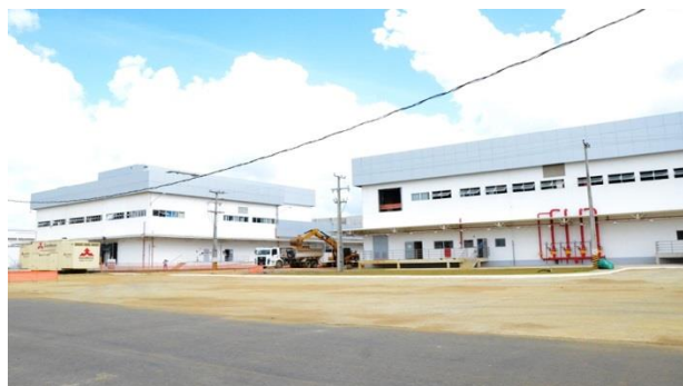
- Vista dos Blocos B01 e B05, jan/2015 -
