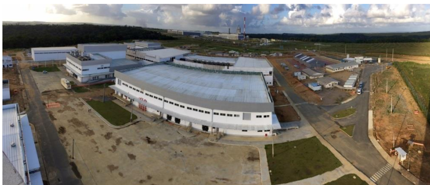
- Vista panorâmica das obras da fábrica em Goiana/PE, dez/2014 -
