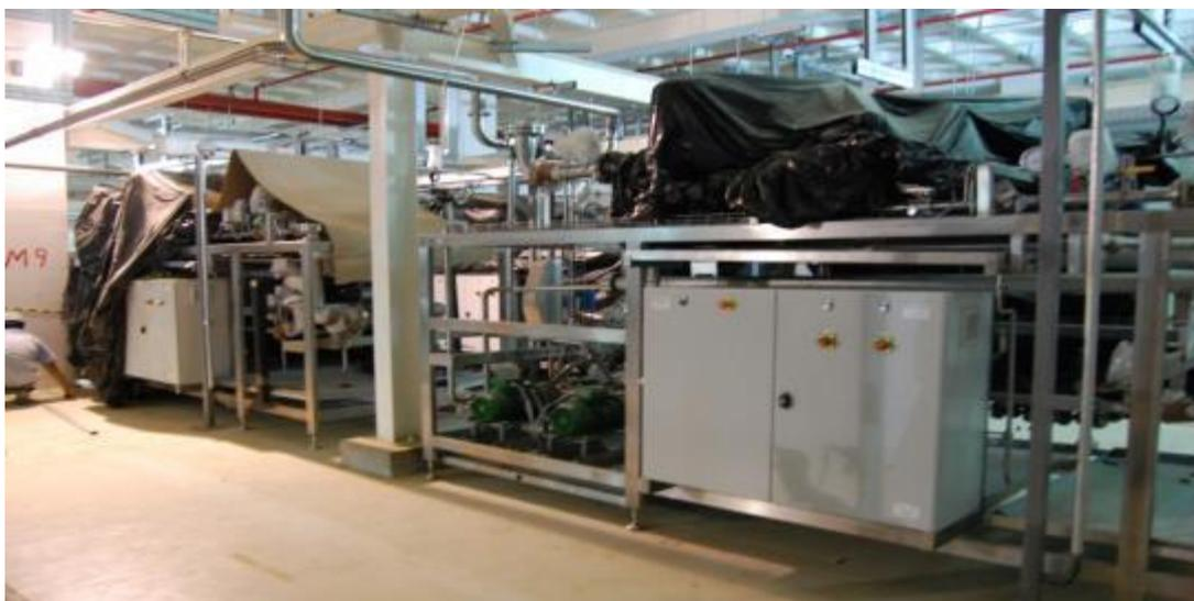
Dois dos 20 Skids do sistema de águas para produção de hemoderivados posicionados no subsolo
